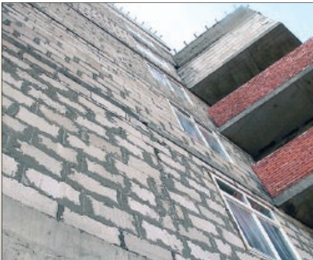
Оконные блоки установлены не в единой плоскости относительно «общей» плоскости будущего утепленного фасада, что приведет к образованию разных по ширине внешних оконных откосов.
